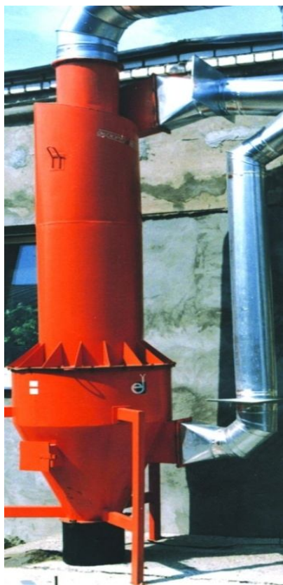
Rys. 7. Wirowy odpylacz cyklonowy dla dwustopniowych systemów oczyszczania Fig. 7. The vortex cyclonic unit for two-level air-cleaning systems
