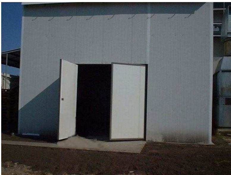
Fot. 2. Widok całości budynku hali podczyszczalni ścieków Phot. 2. View of the whole sewage pre-treatment plant hall
